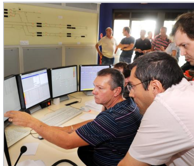
Poste d'aiguillage sous tension à quelques minutes de la reprise du trafic. (Photo Pierre MATHIS)
